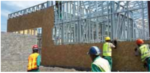
Sealtight Vaal – LWS Mini Warehouse
