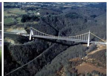
Chavanon Viaduct Frankrig
